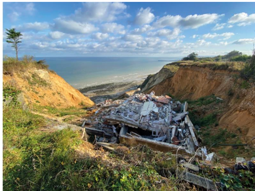
Figure 1 : Bâtiment détruit en raison du recul d'une falaise. Cerema
