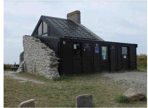
Figure 45 : Maison du littoral à Trégunc (Photo : M. De Baets)
